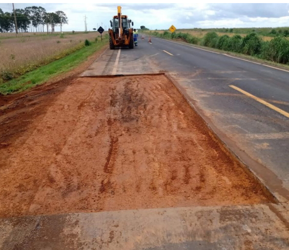
Antes do serviço de reparo localizado em trecho da MS-306
