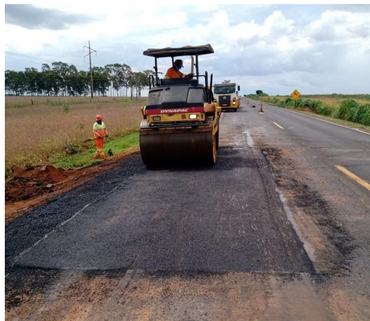
Depois do serviço de reparo localizado em trecho da MS-306
